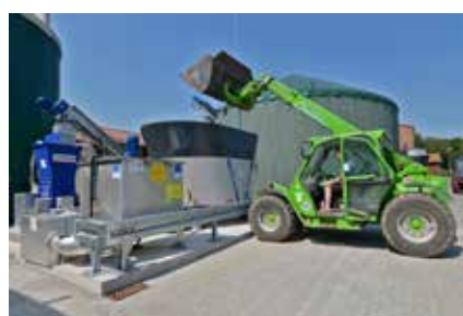
Direkte Befüllung des Fermenters mit festem Substrat
