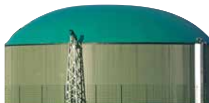
Fermenter: Kernstück der Biogasanlage
