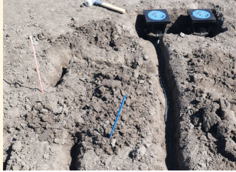
^ ... dabei müssen die Sensorkabel in kleinen Gräben zu den Sendeeinheiten in die Bodenschächte verlegt werden.
