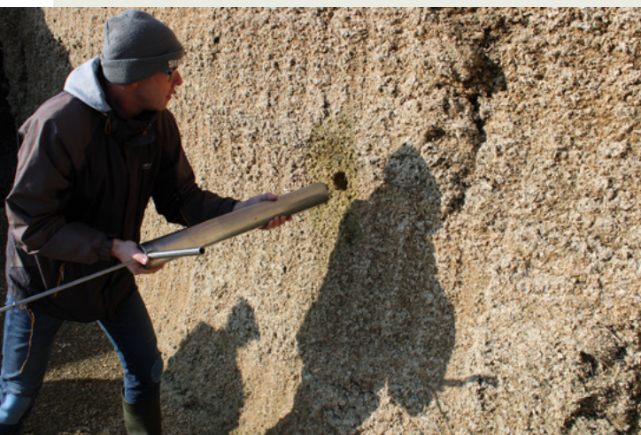
Abb. 48: Entnahme des Probebohrers mit Probekern
