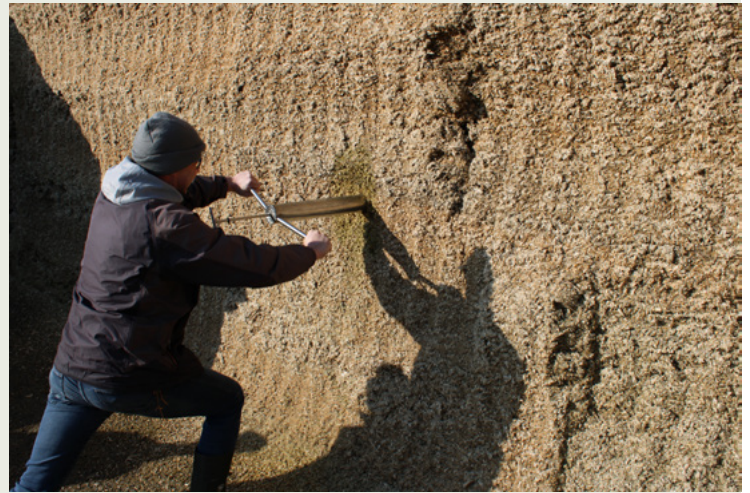
Abb. 47: Verwendung eines geeigneten Probebohrers mit definiertem Probekern am Silostock
